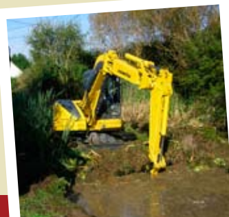
Restauration en cours à Vallon-en-Sully.
