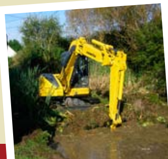
Restauration en cours à Vallon-en-Sully.
